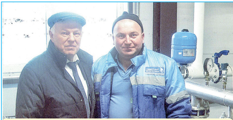
Депутат Госдумы РФ Грешневиков А.Н. проверяет работу станции обезжелезивания в с. Новый Некоуз.
